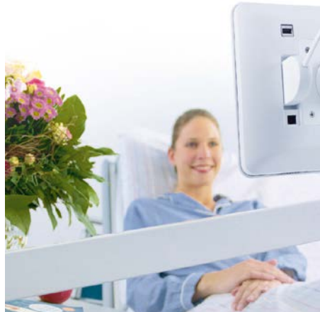
Der normgerechte Betrieb der Rufanlage gibt ein sicheres Gefühl.
